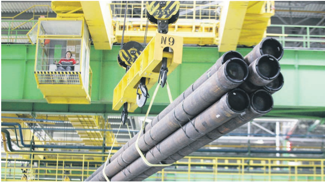
▲ ТЭЦ-1 работает с июля © АРХИВ ОМК
