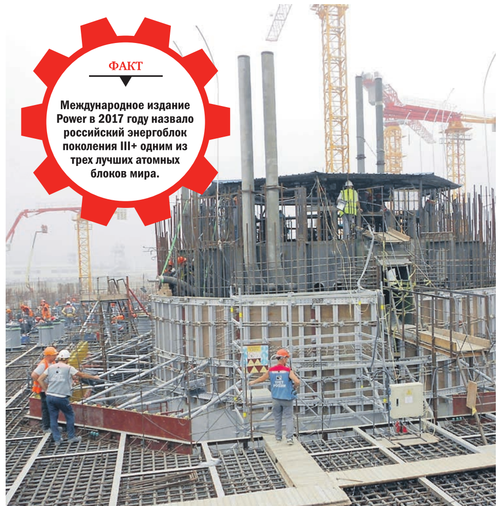
△ Первый энергоблок АЭС «Руппур» запустят в 2023 году © АРХИВ ОМК
